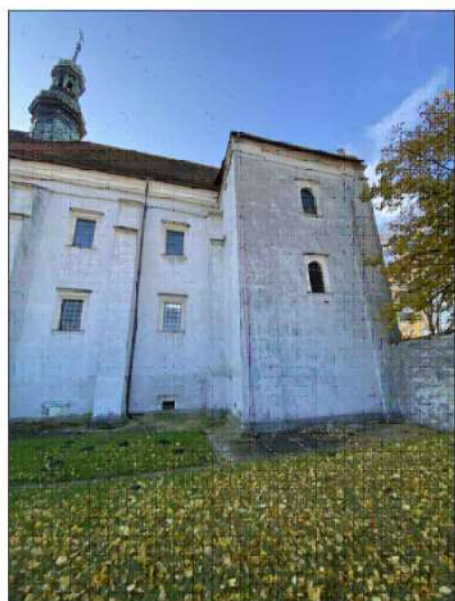
FOT. BUD. KOŚCIOŁA, ELEWACJA PÓŁNOCNA 01
