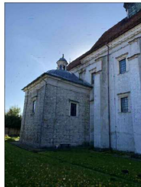
FOT. BUD. KOŚCIOŁA, ELEWACJA PÓŁNOCNA 06 KAPLICA
