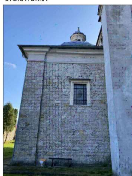
FOT. BUD. KOŚCIOŁA, ELEWACJA PÓŁNOCNA 07 KAPLICA, ELEWACJA ZACHODNIA
