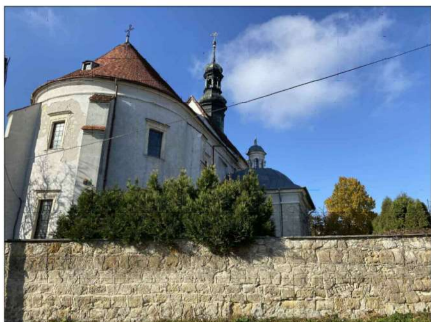
FOT. BUD. KOŚCIOŁA, ELEWACJA WSCHODNIA 05 NAROŻNIK PÓŁNOCNO-WSCHODNI 03
