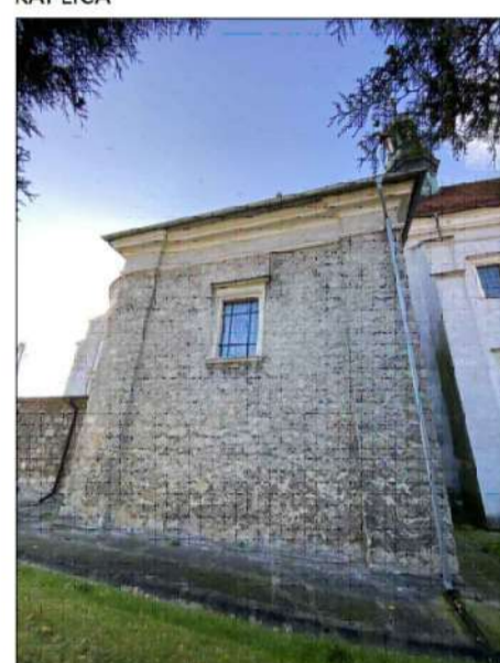
FOT. BUD. KOŚCIOŁA, ELEWACJA PÓŁNOCNA 07 KAPLICA, ELEWACJA PÓŁNOCNA
