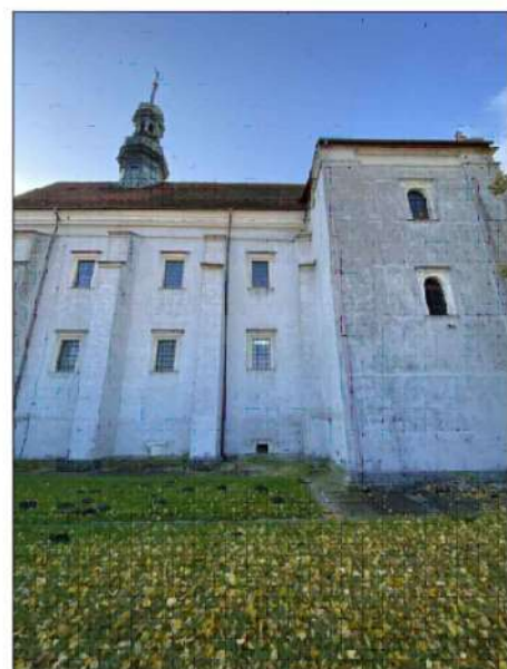
FOT. BUD. KOŚCIOŁA, ELEWACJA PÓŁNOCNA 02
